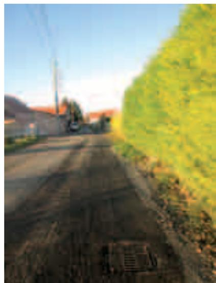
**A Martinges**, la portion de la rue de la Mare effectuée l'an dernier reste décevante en dépit d'un drain et d'un regard rajoutés et du changement de la base de cailloux semble-t-il trop « terreux ». Les nouvelles constructions se poursuivent sur cette rue. Une fois terminées, des travaux de voirie plus importants devront être envisagés.
